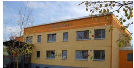
Abb. 46: Sanierte kommunale Kita „Bertolla“
