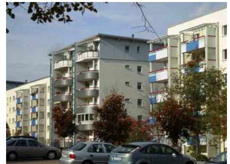
Abb. 3: Umgebaute Wohngebäude in Winzerla
