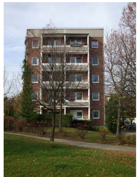
Abb. 31: Plattenbau ohne sanierte Außenhaut – aber immer mit Blick ins Grüne, hier Ernst-Zielinski-Straße
