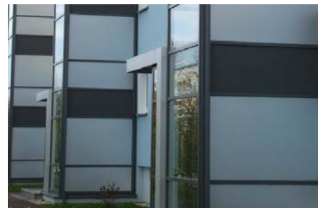
Abb. 34: Neue Fassaden und angebaute Aufzüge
