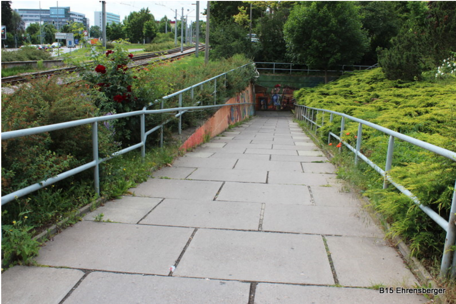
Betonplatten 120/120 cm, vorhanden
