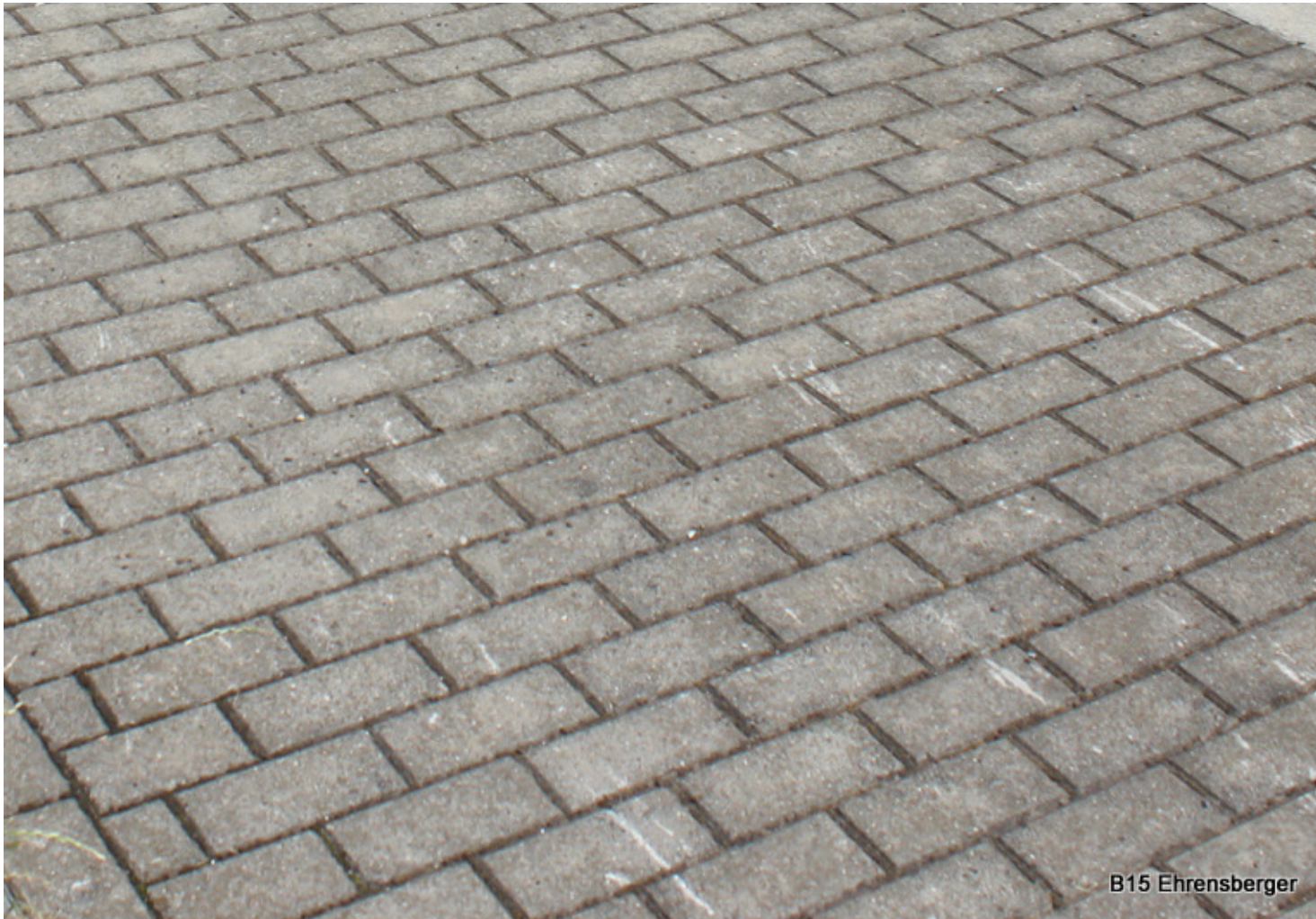
Betonpflaster 20/10 cm, vorhanden
