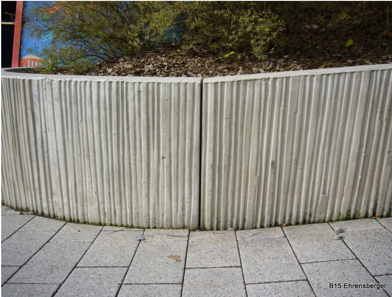
Winkelstützen, mittels Matritzen strukturiert, Fa. Reckli, Modell 2/32 „Inn“
