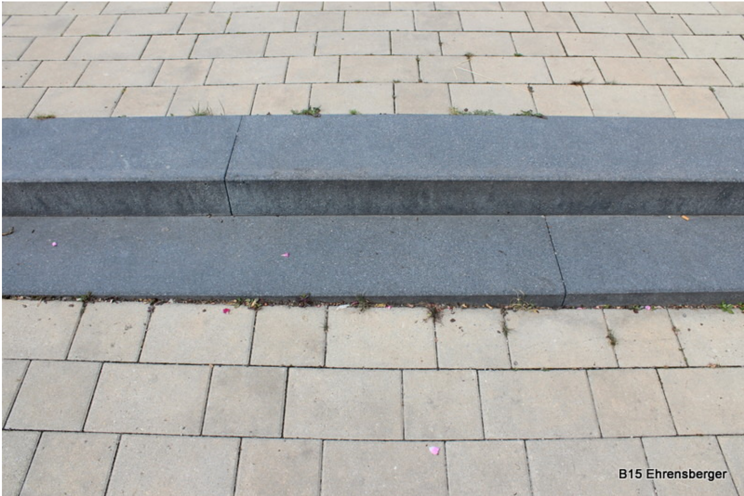
Betonpflaster 20/20 cm und 20/30 cm
