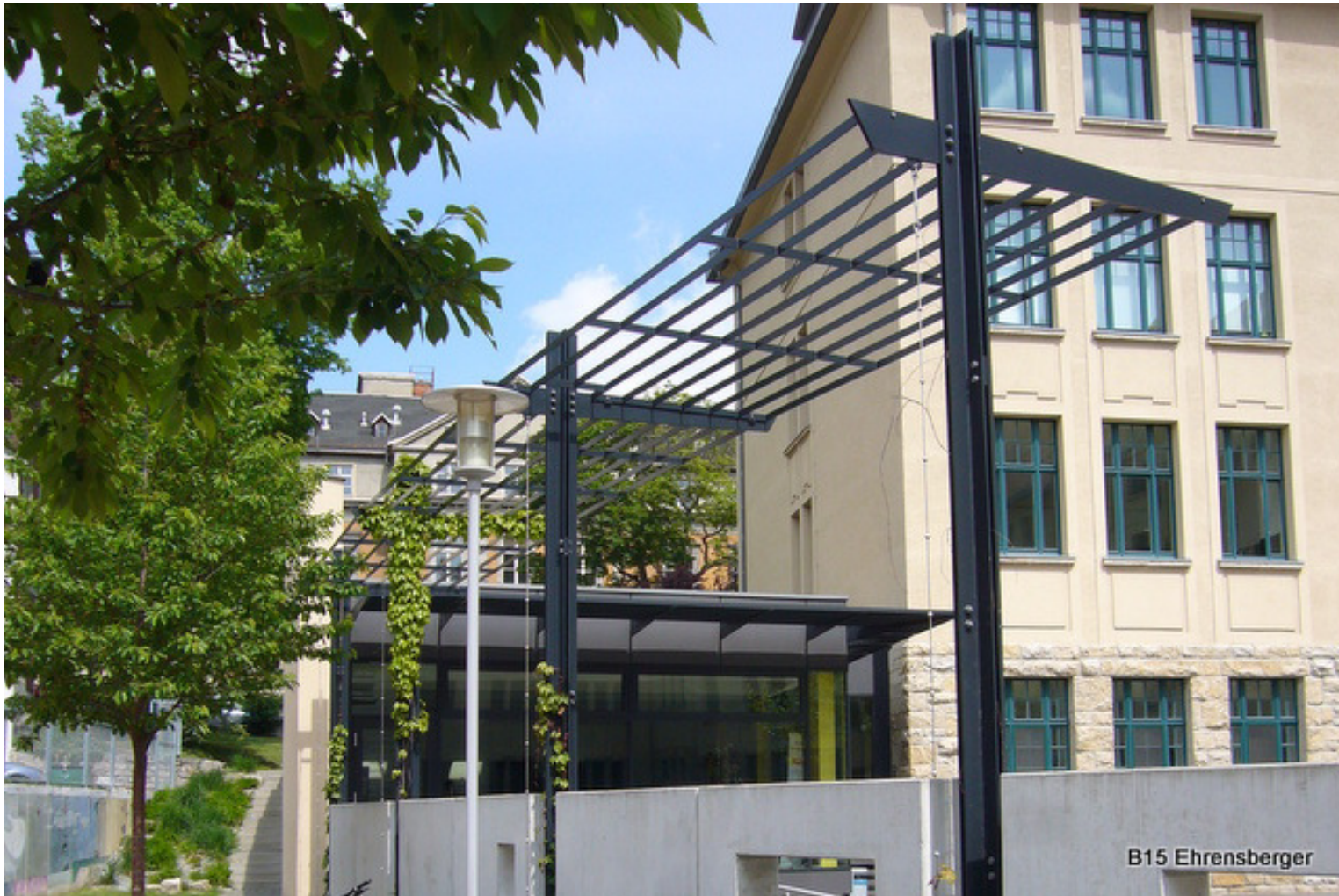
Stahl-Pergola, 3,80 m hoch, verzinkt und pulverbeschichtet RAL 7016 anthrazit-grau
