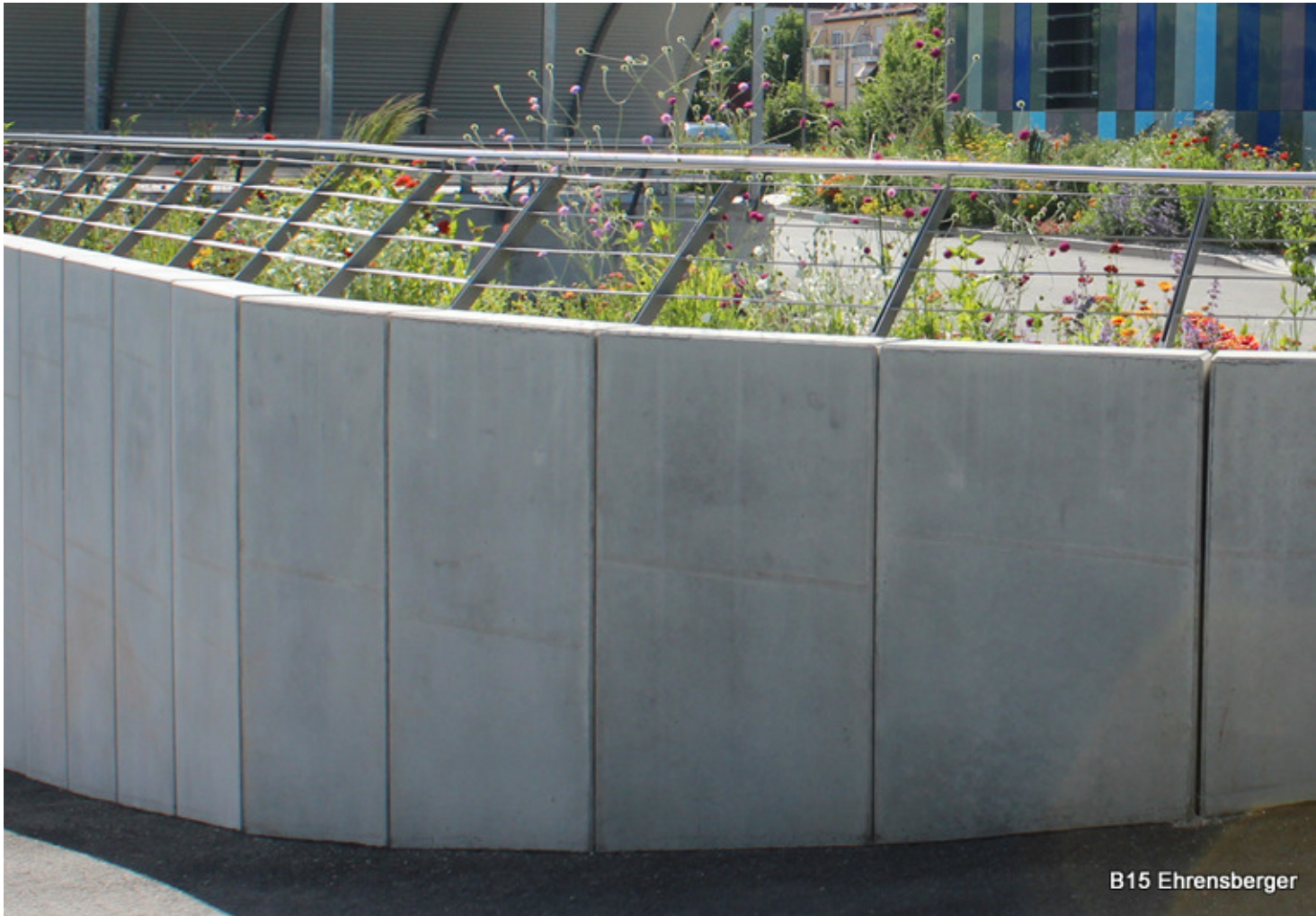
Winkelstützen, Oberfläche glatt, Sichtbeton
