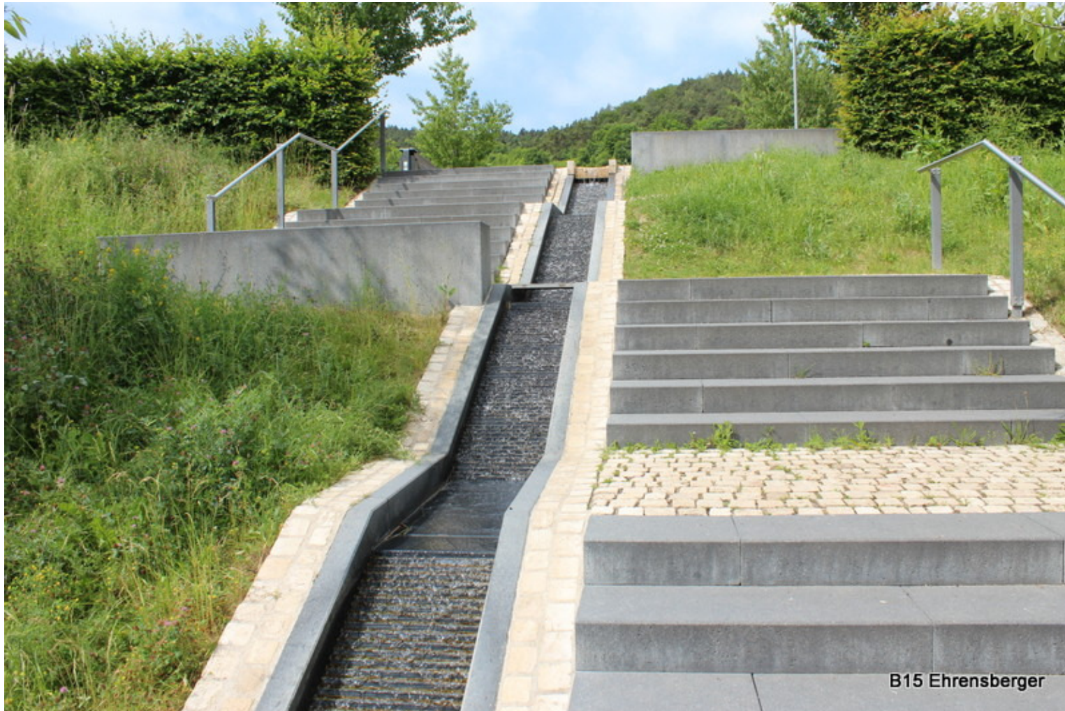
Treppenanlage, Blockstufen anthrazit
