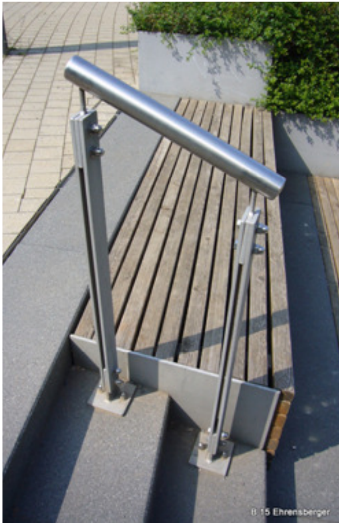
Handläufe, Geländer wie vorhanden
